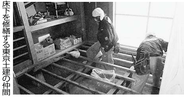
床下を修繕する東京土建の仲間
