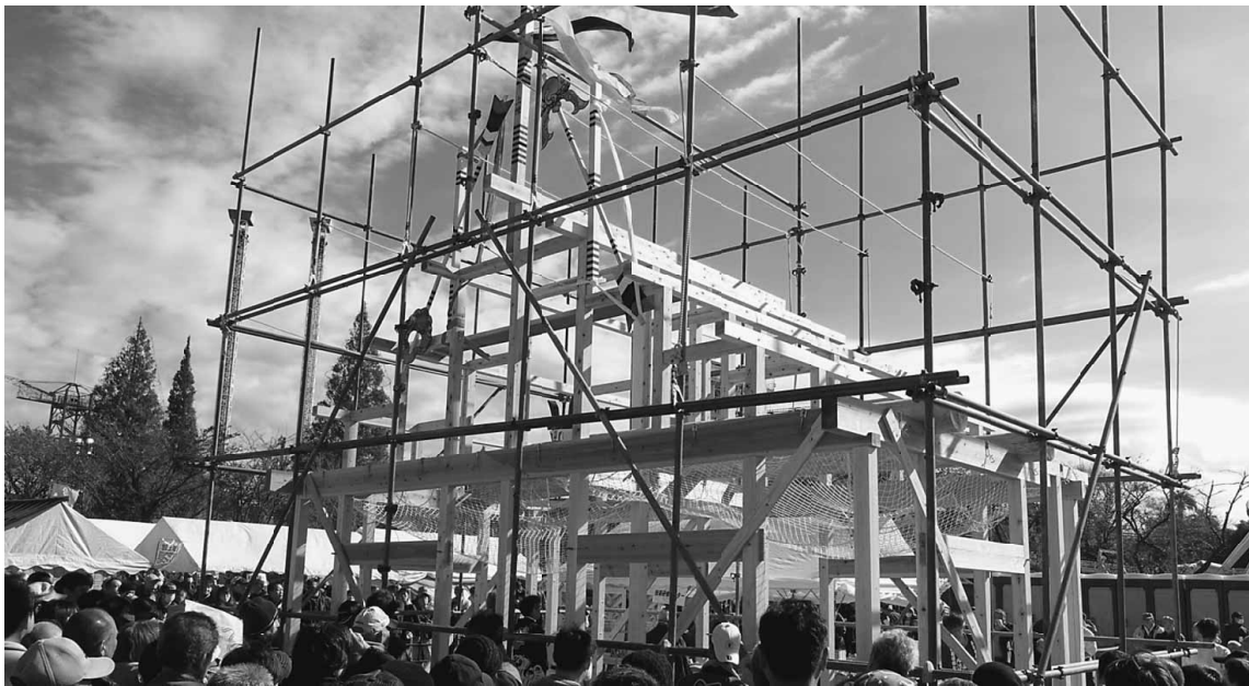
東京土建のイベントならではの上棟式、職人の技術の見せどころです
