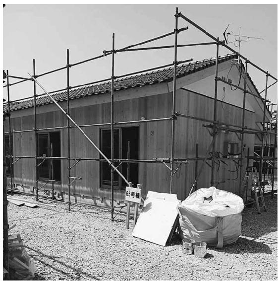
永田さんが手掛けた仮設住宅の65号棟
